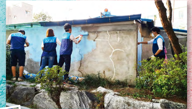
먼지가 정말 심하게 났다. 하지만 사포질을 꼼꼼히 해야지 벽화가 곱게 그려진다. 사포질 후 밑바탕을 칠한다.
